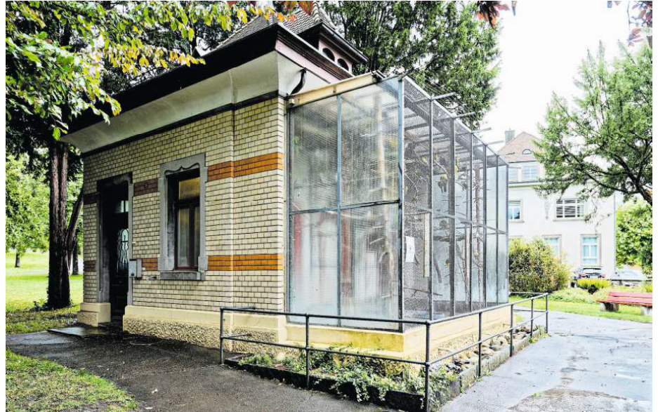
Nach turbulenten Zeiten soll die Vogelvoliere im Stadtpark Arbon demnächst saniert werden.
