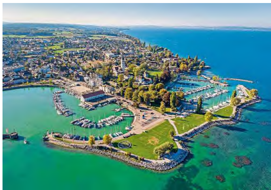
Ein Seewasser-Wärmeverbund Romanshorn soll künftig zahlreiche Gebäude mit umweltfreundlicher Wärme aus dem Bodensee versorgen. z.v.g.
